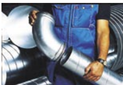
Монтаж элементов системы Lindab Safe.
